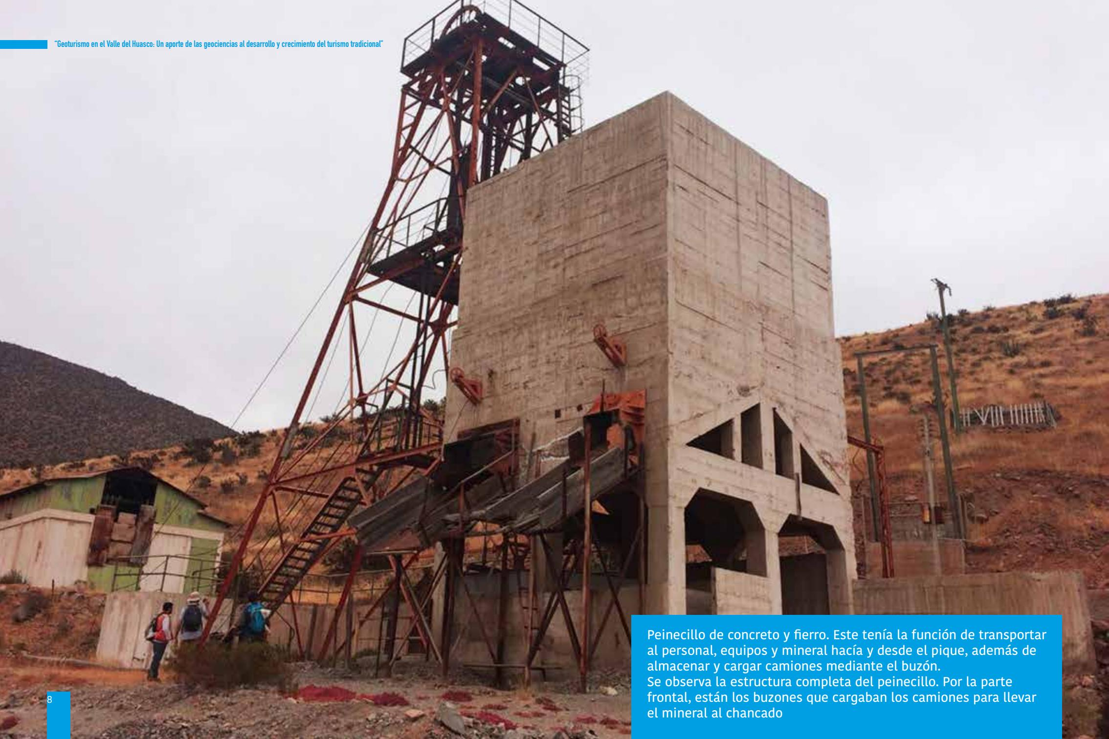
Peñecillo de concreto y fierro. Este tenía la función de transportar al personal, equipos y mineral hacía y desde el pique, además de almacenar y cargar camiones mediante el buzón. Se observa la estructura completa del peñecillo. Por la parte frontal, están los buzones que cargaban los camiones para llevar el mineral al chancado
