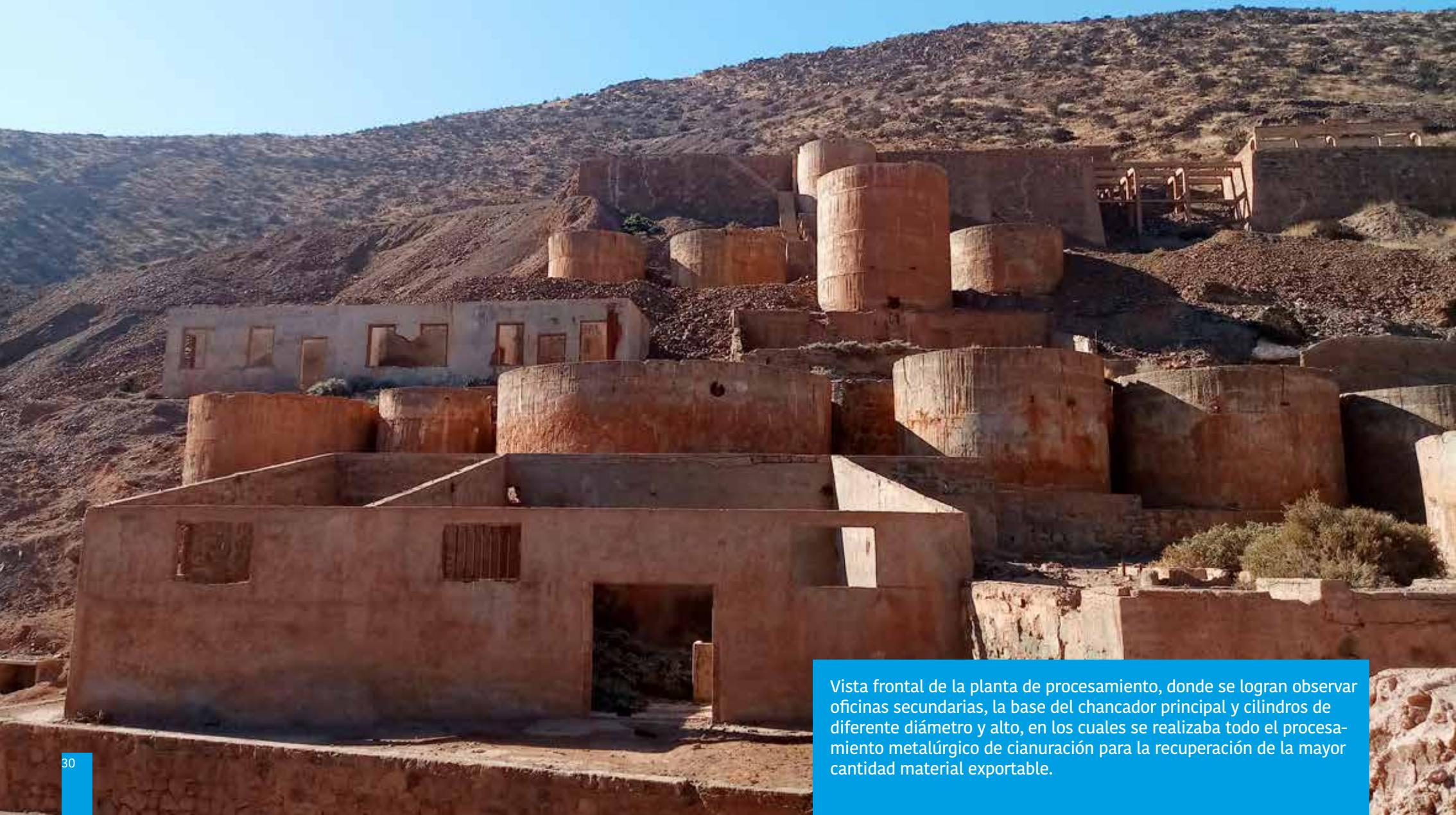
Vista frontal de la planta de procesamiento, donde se logran observar oficinas secundarias, la base del chancador principal y cilindros de diferente diámetro y alto, en los cuales se realizaba todo el procesamiento metalúrgico de cianuración para la recuperación de la mayor cantidad material exportable.
