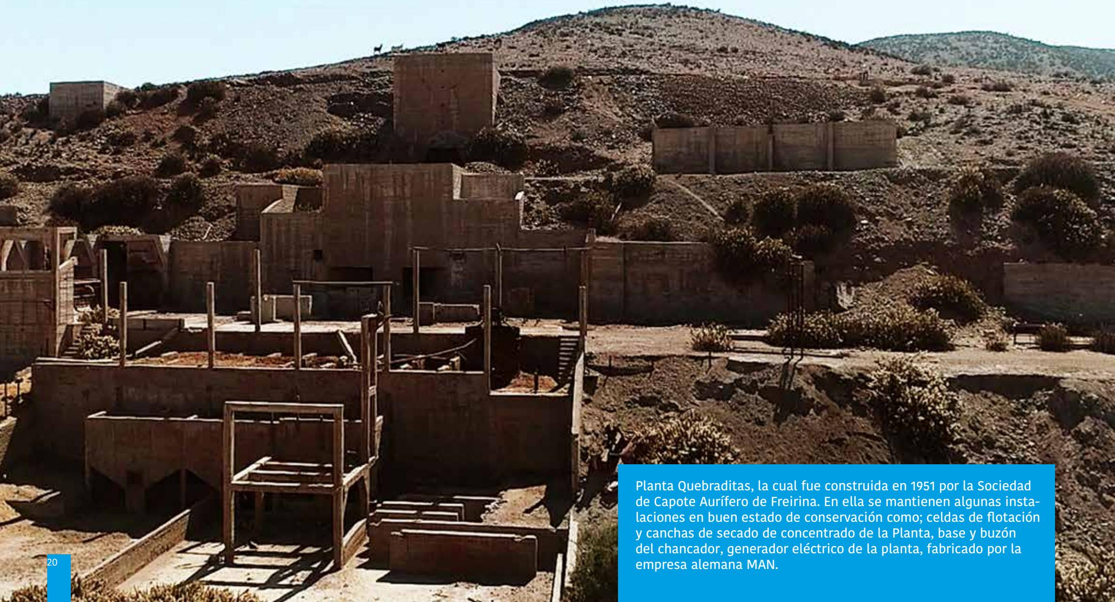
Planta Quebraditas, la cual fue construida en 1951 por la Sociedad de Capote Aurífero de Freirina. En ella se mantienen algunas instalaciones en buen estado de conservación como; celdas de flotación y canchas de secado de concentrado de la Planta, base y buzón del chancador, generador eléctrico de la planta, fabricado por la empresa alemana MAN.
