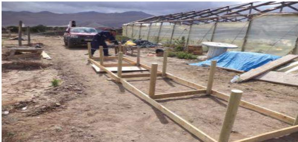
Figura 7. Construcción del mesón para sistema de raíz flotante en el campo de agricultor, Hacienda San Pedro, Copiapó.
