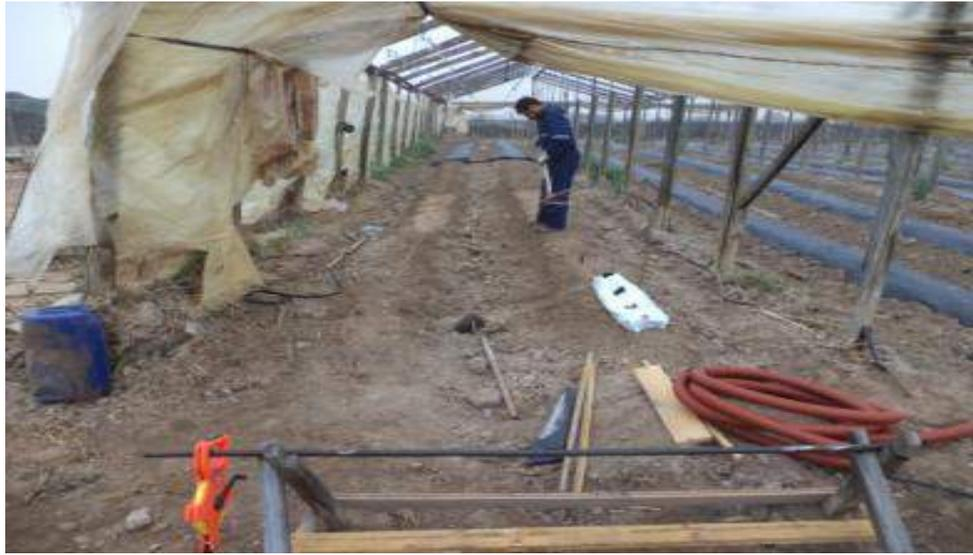
Figura 6. Implementación unidad de validación en el campo del agricultor, trabajos de nivelación de suelo de la superficie de al interior del invernadero, Hacienda San Pedro, Copiapó.
