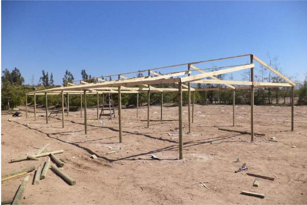
Figura 3. Construcción invernaderos Centro Experimental Huasco, Vallenar.
