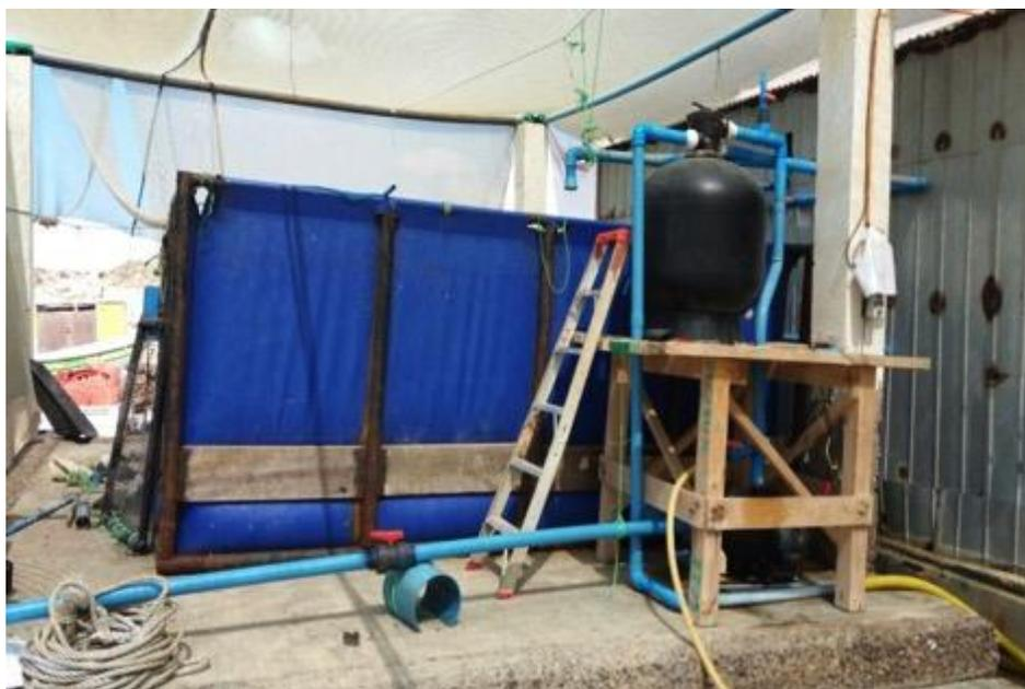
**Figura N°8: Estanque de cabecera y sistema de filtración.**
