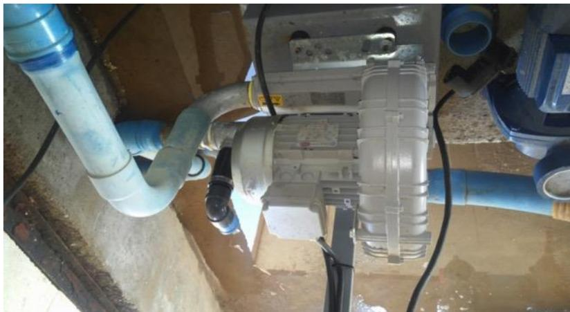
*Figura 4: Blower instalado para suministro de aire.*
