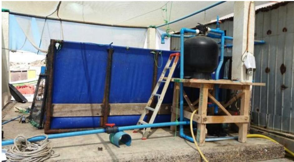
Estanque de cabecera y sistema de filtración de agua.
