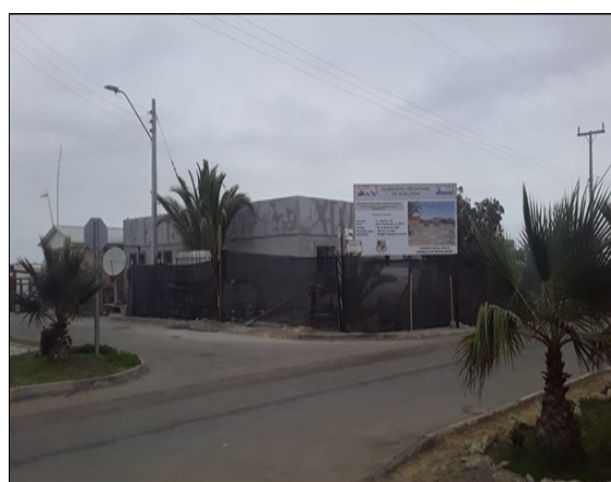
Fotografía, PSR Carrizalillo, recinto provisorio mientras se realiza la ejecución "Proyecto Reposición Posta
