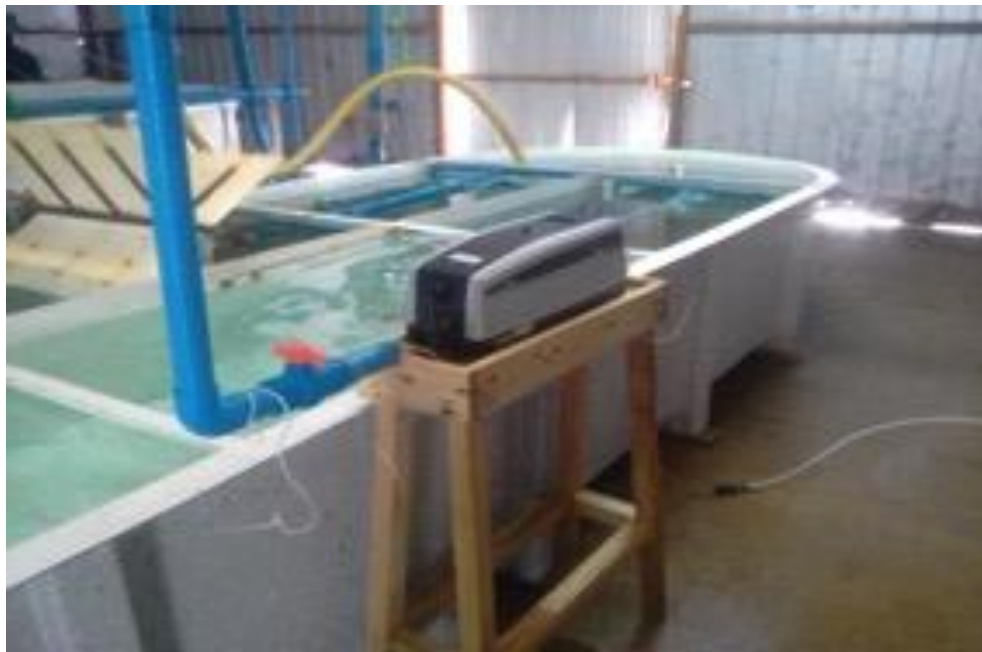
Figura 23. Bomba de calor o “heater”
