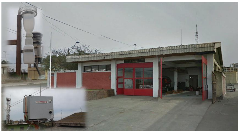
Figura 40. Estación de monitoreo Bomberos Huasco.
