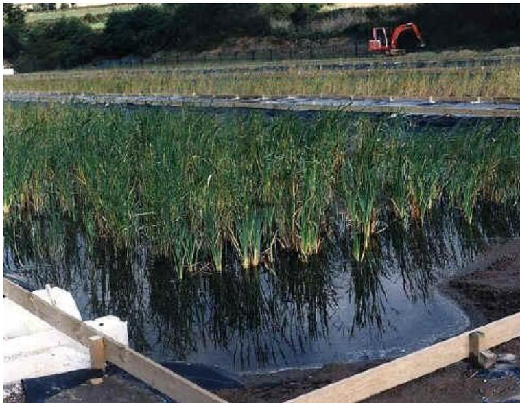
**Figura 3.** Construcción del sistema de tratamiento pasivo de aguas residuales mineras en la mina Wheal Jane, condado de Cornwall, Inglaterra.
