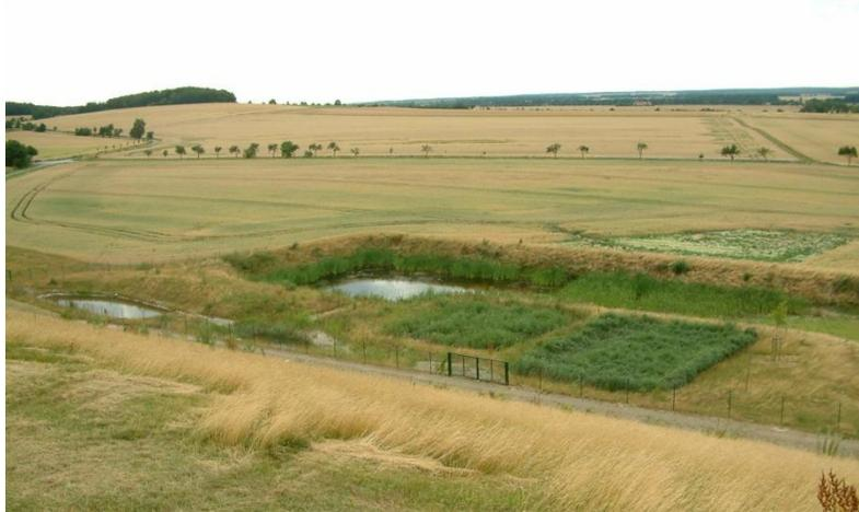
**Figura 9.** Sistema de tratamiento de aguas industriales de mediano tamaño, tipo pasivo-biológico, instalado en Alemania.
