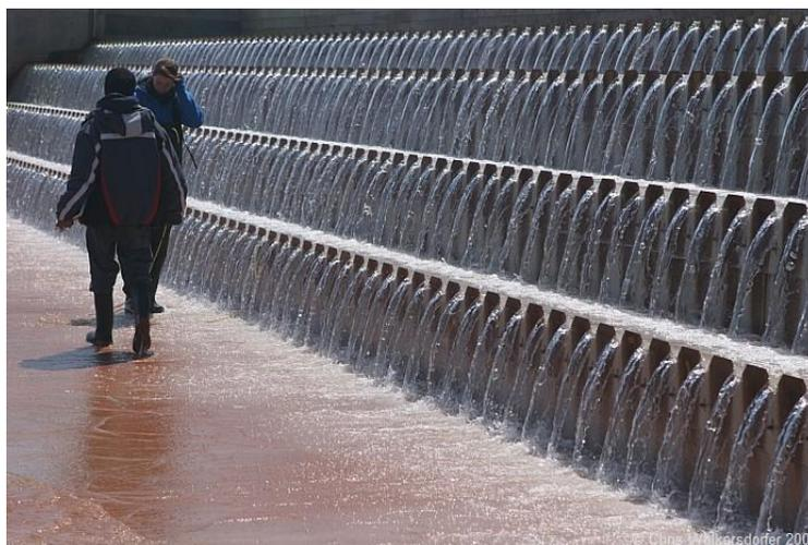
**Figura 6.** Cascadas de aireación en Nueva Escocia, Canadá.
