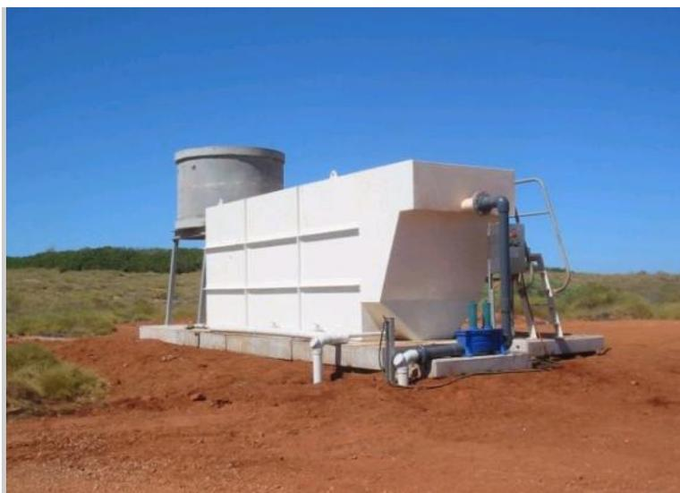
**Figura 4.** Planta de tratamiento de aguas industriales compartimentalizada, lista para ser transportada e instalada en terreno.
