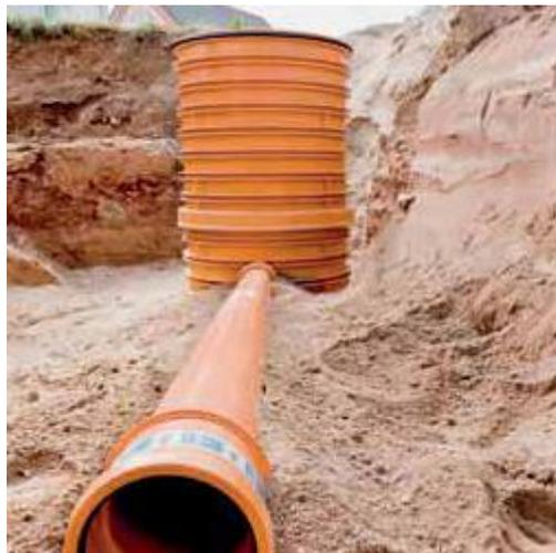
**Figura 21.** Pozo de monitoreo plástico, prefabricado.
