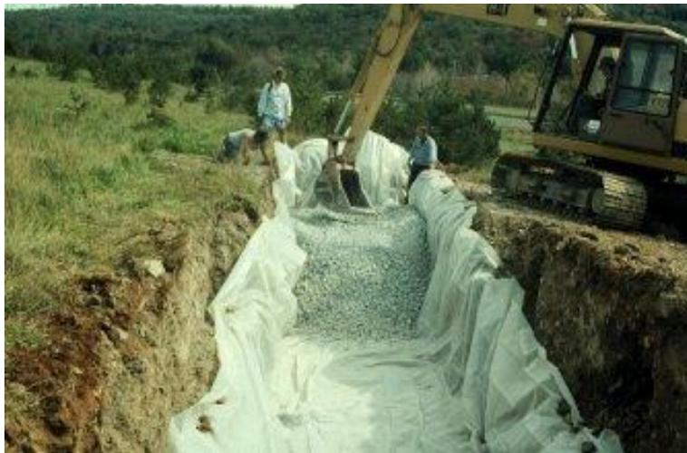
**Figura 5.** Construcción de una barrera reactiva, usando piedra caliza como material encalante y plástico como sellante. La operación usa el gradiente natural.
