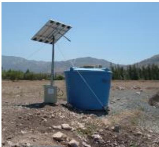
**Figura 12.** Ejemplo de una planta solar pequeña para la generación de la energía eléctrica requerida en la planta de tratamiento de aguas.
