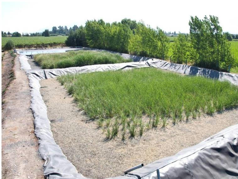
**Figura 8.** Sistema para el reciclaje de aguas residuales industriales instalado en Chile de tipo pasivo-biológico de pequeño tamaño.
