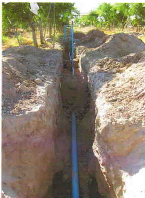
Figura 67. Arranque de riego y válvulas programables en el huerto de Unifrutti.
